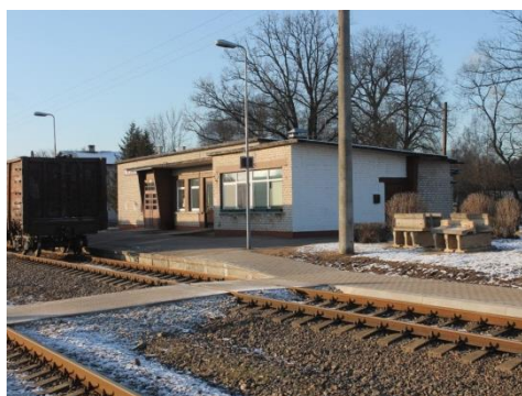
Inčukalna dzelzceļa stacija
